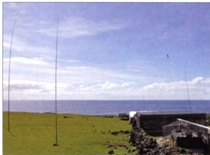
Blick auf vier der eingesetzten Vertikalantennen (80 m, 40 m, 30 m und 17 m) mit freier Abstrahlung über den Atlantik in Richtung Nordwesten/USA
